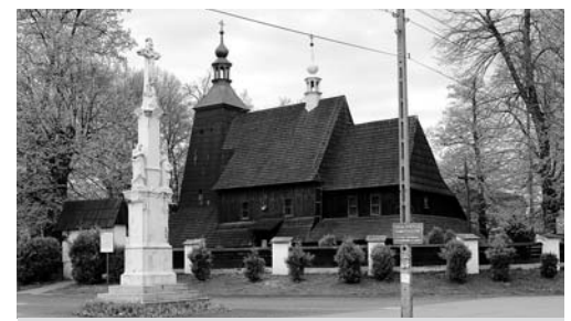
Dach kościoła w Grzawie impregnowany powinien być co 5-6 lat (fot. pk)
